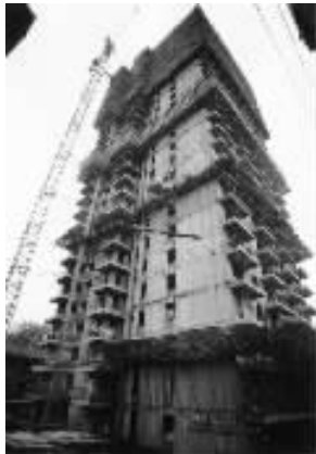
图 1 悬挑式外脚手架
